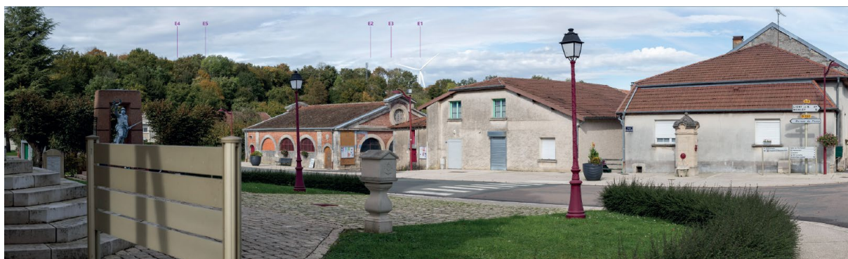
Figure 2 : Vue n°44 - Depuis les abords de la Mairie de Montiers-sur-Saulx
