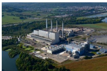
Figure 3 : Centrale thermique à Gaz de Blénod (54)
